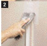
Наложите тонкий слой шпатлевки для наложения соединительной ленты (taping compound) на ленту выше. Вдавите ленту вдоль шва в шпатлевку. Проведите шпателем по ленте, чтобы удалить лишнюю шпатлевку, ниже.
