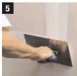
После того, как слой шпатлевки на соединительной ленте высох, наложите финишную шпатлевку с минимальной усадкой (topping compound) шириной 20-25см. на шов и шурупы или саморезы.
