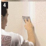
Наложите тонкий слой шпатлевки на ленту, выше; наложите финишную шпатлевку, универсальную шпатлевку или шпатлевку с химическим отвердителем на шурупы или саморезы, выше.
