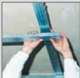
Перед монтажом КНАУФ-листов проверяется качество сборки каркаса (прочность, наличие инородных предметов, ровность). Прогиб каркаса не должен превышать 1/500 длины.
