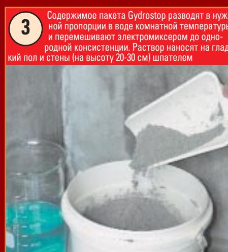
3 Содержимое пакета Gydrostop разводят в нужной пропорции в воде комнатной температуры и перемешивают электромиксером до однородной консистенции. Раствор наносят на гладкий пол и стены (на высоту 20-30 см) шпателем
