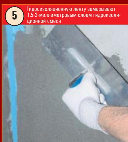
5 Гидроизоляционную ленту замазывают 1,5-2-миллиметровым слоем гидроизоляционной смеси
