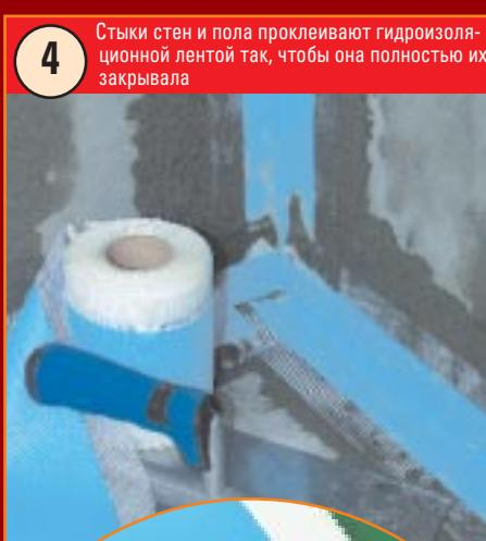
4 Стыки стен и пола проклеивают гидроизоляционной лентой так, чтобы она полностью их закрывала
