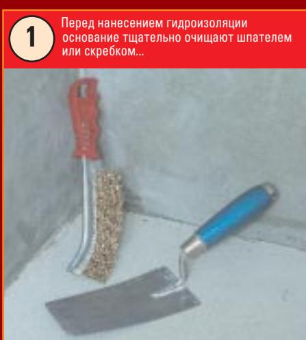
1 Перед нанесением гидроизоляции основание тщательно очищают шпателем или скребком...
