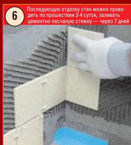
6 Последующую отделку стен можно проводить по прошествии 3-4 суток, заливать цементно-песчаную стяжку — через 7 дней
